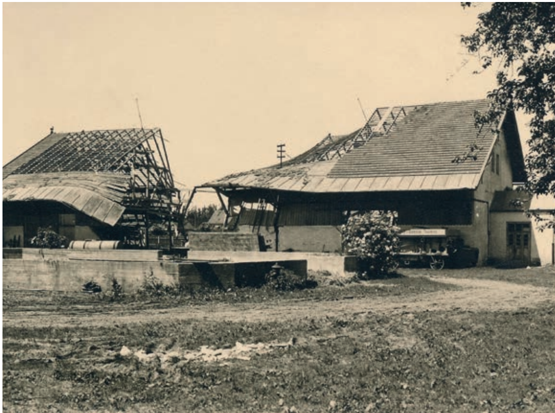
Das am 11. April 1945 durch Bombeneinschlag zerstörte Ökonomiegebäude
